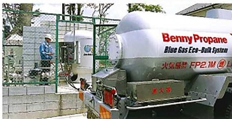
バルク貯槽に充てん作業中
